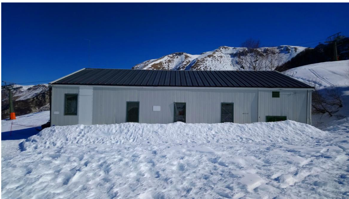
Figura 9 – Vista esterna della stazione di pompaggio 400
